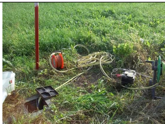
Punto AV-CV-SO-1-02 Spurgo
