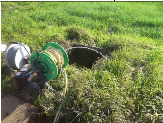
Punto AV-CV-SO-1-33. Spurgo
