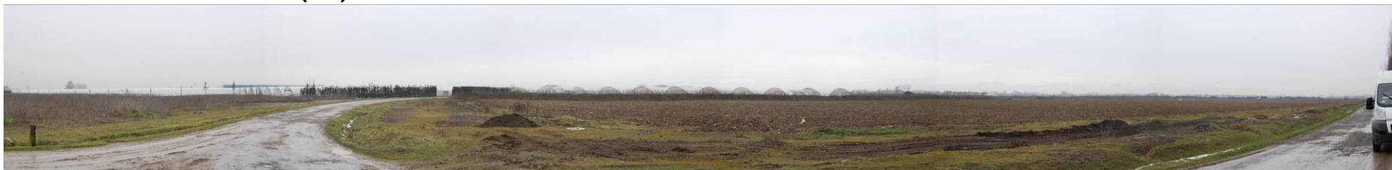
Foto 32 - Stazione AV-BN-PA-1-09 (I CO)
