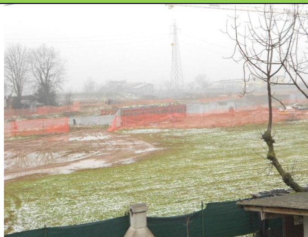
Vista cantiere BBM da finestra 2° piano f.t.
