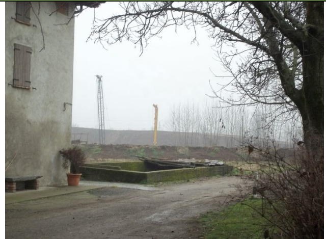
Vista cantiere BBM
