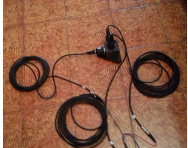
Posizionamento accelerometri monoassiali, 2° piano f.t.
