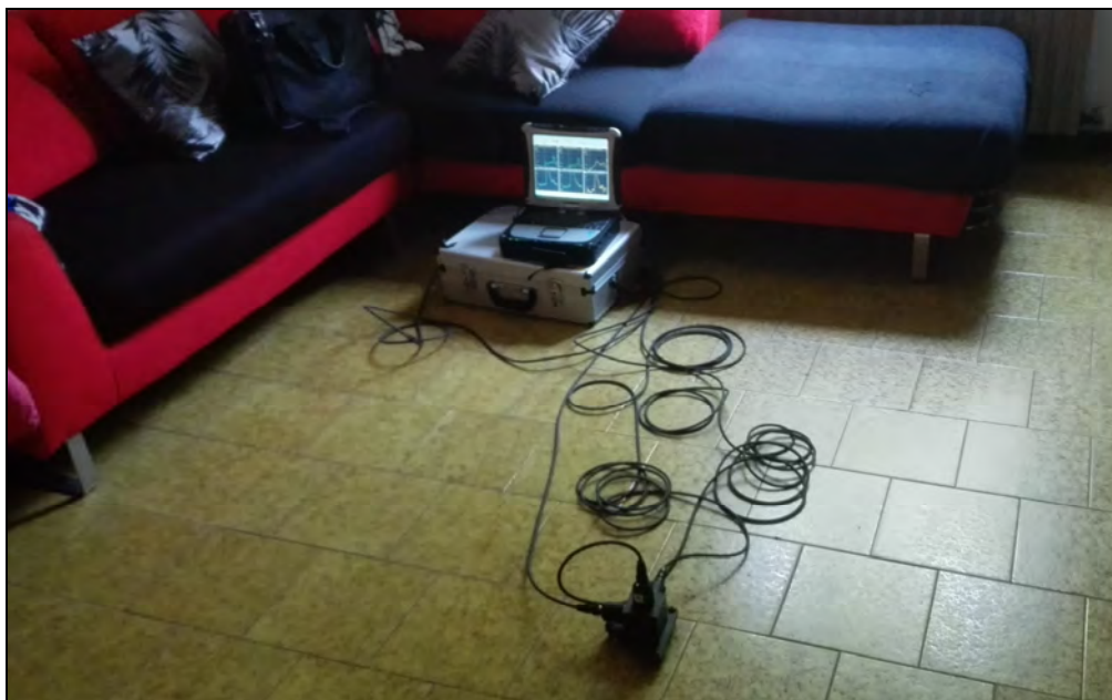
Posizionamento accelerometro triassiale, 2° piano f.t.
