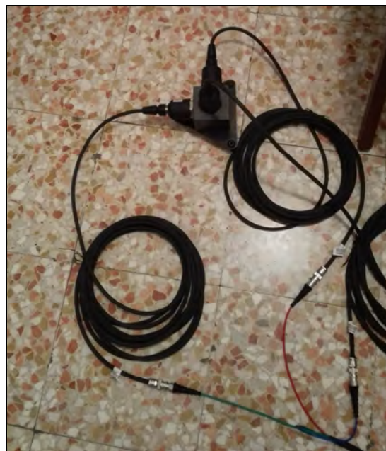
Posizionamento accelerometri monoassiali, 2° piano f.t.
