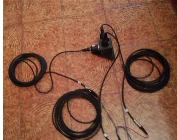
Posizionamento accelerometri monoassiali, 2° piano f.t.
