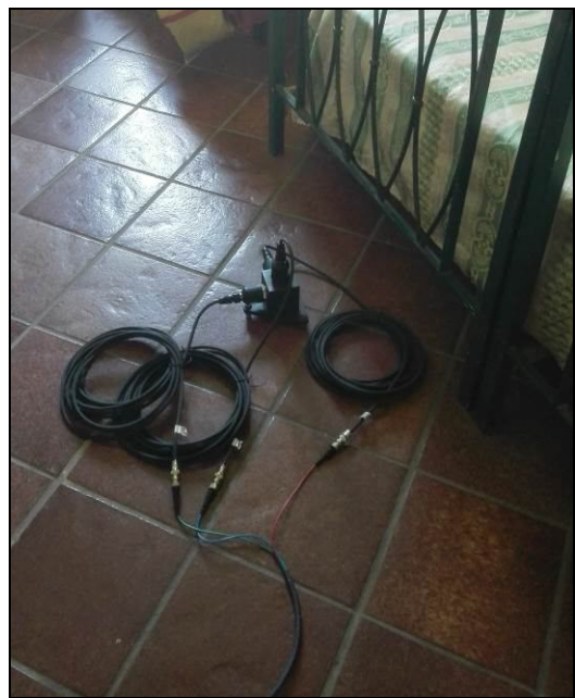
Posizionamento accelerometro triassiale, 3° piano f.t.
