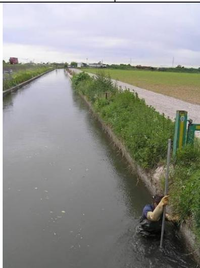
Il profilo di Roggia Trezana nella stazione di monte è totalmente artificiale e sagomato: entrambe le sponde ed il fondo sono cementati, impedendo la formazione di un substrato idoneo all'instaurarsi di una
