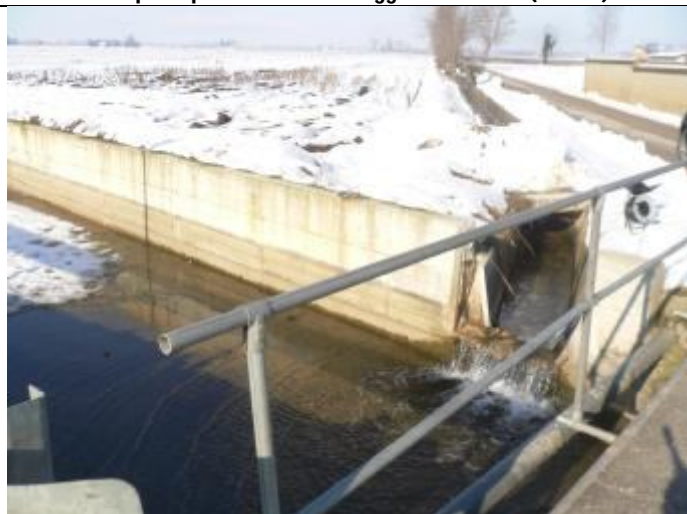
Canale laterale Roggia Castellana (Monte)
