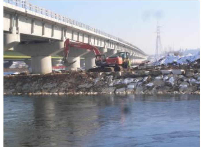
Fiume Oglio (Valle) sistemazione sponda mese di febbraio
