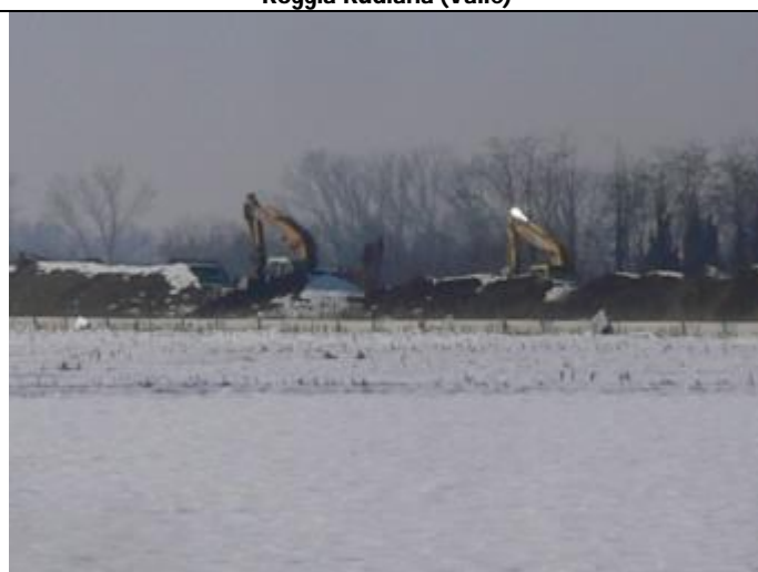
Lavorazioni lungo il rilevato R116 Roggia Rudiana (Valle)
