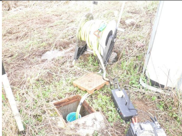
Punto AV-RO-SO-1-13. Spurgo
