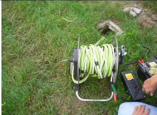
Punto AV-CT-SO-1-29. Spurgo
