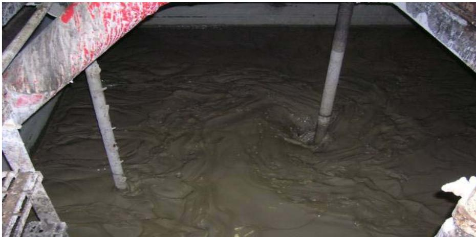
Si evidenzia che il circuito del fluido di perforazione è un “sistema chiuso” nel quale il continuo monitoraggio del fango circolante (sia qualitativo che quantitativo) contribuisce ad aumentare la sicurezza delle operazioni.
