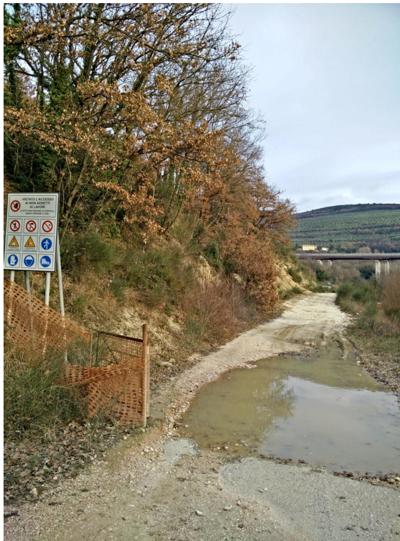
Figura 7 - Immagine della pista in fase di produzione
