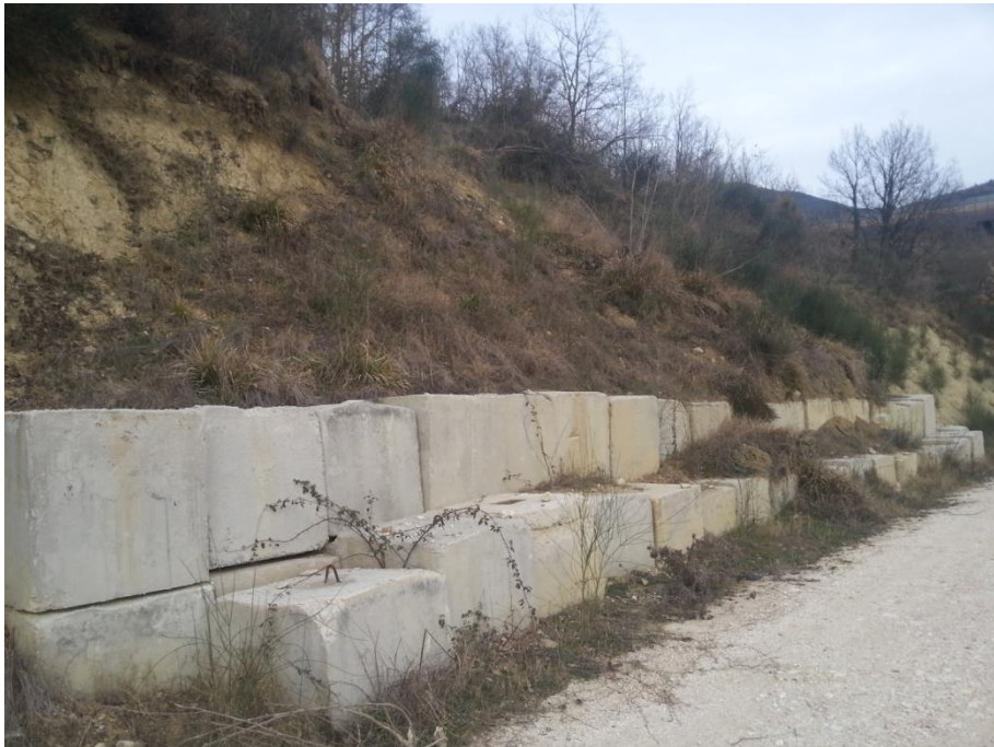
Figura 9 - Immagine della pista in fase di produzione
