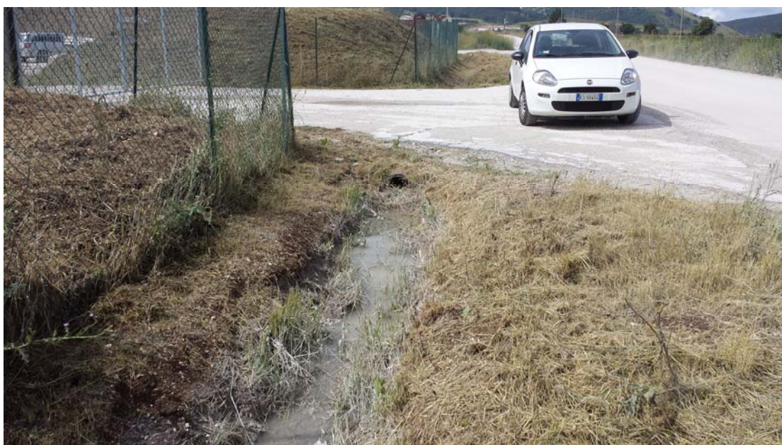
Foto 6—Guado provvisorio in corrispondenza di uno degli accessi al cantiere
