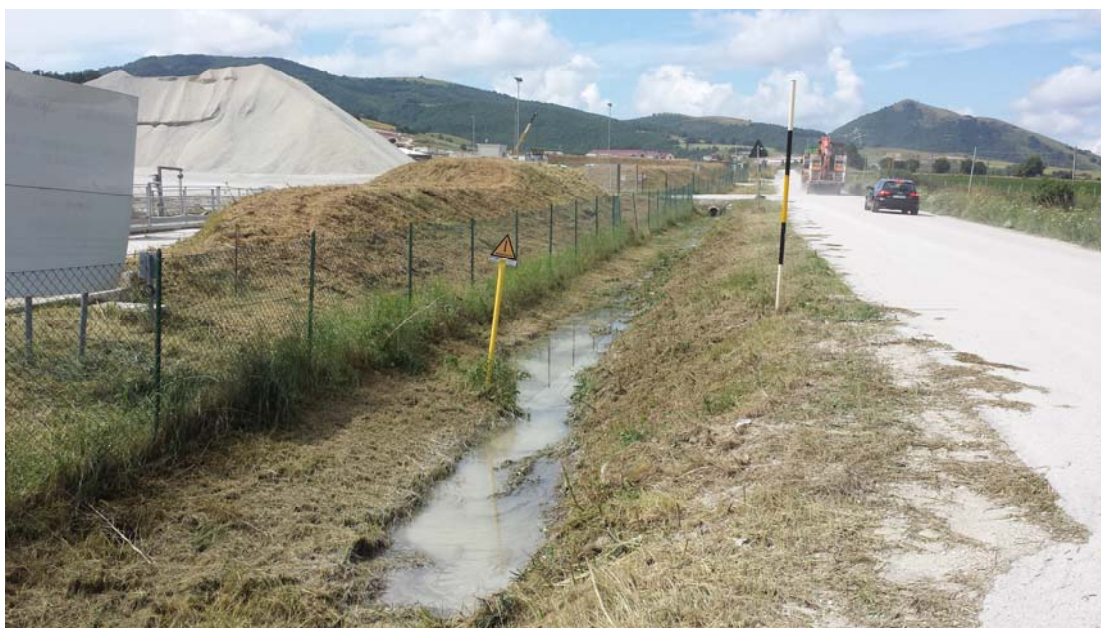
Foto 3–Fosso di guardia lungo la S.P. 50 “Fonte delle Mattinate” che costeggia le due aree di cantiere F2B3 e PC2.
