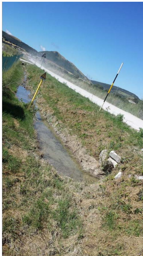
Foto 4 e 5–Tombino di scarico del fosso di guardia sotto la S.P. 50 “Fonte delle Mattinate”
