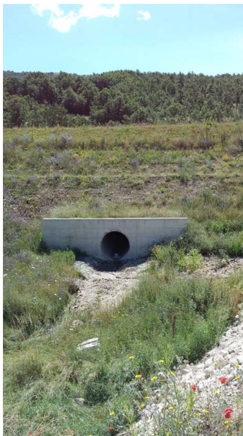
Foto 1 e 2–Tombini di restituzione acque di versante sotto la strada di progetto in prossimità della contigua area di betonaggio F2B3
