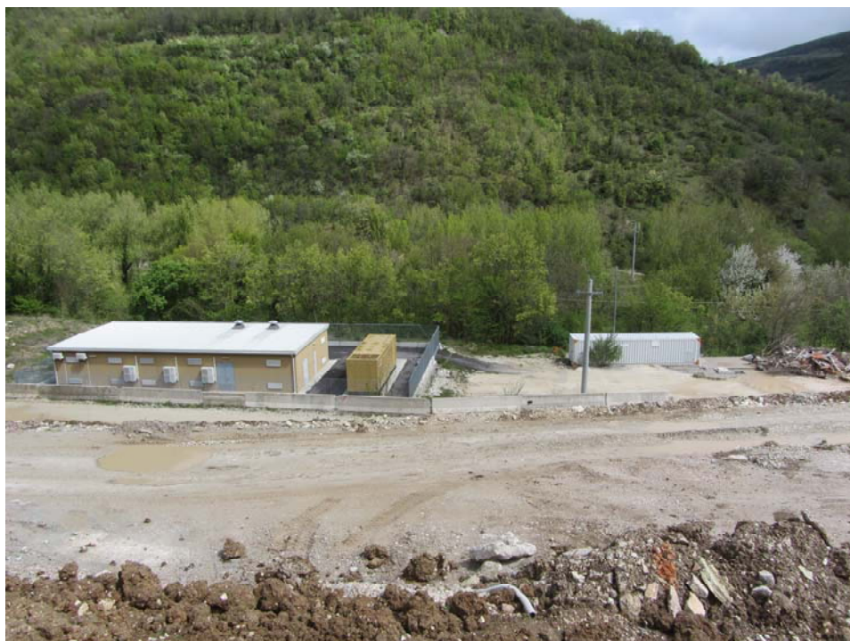
Figura 6.c - Immagine dell'area in fase di cantiere
