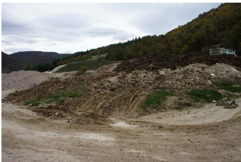
Figura 6.f - Immagine dell'area in fase di cantiere
