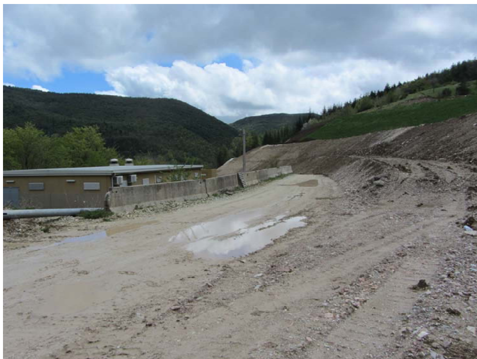
Figura 6.e - Immagine dell'area in fase di cantiere
