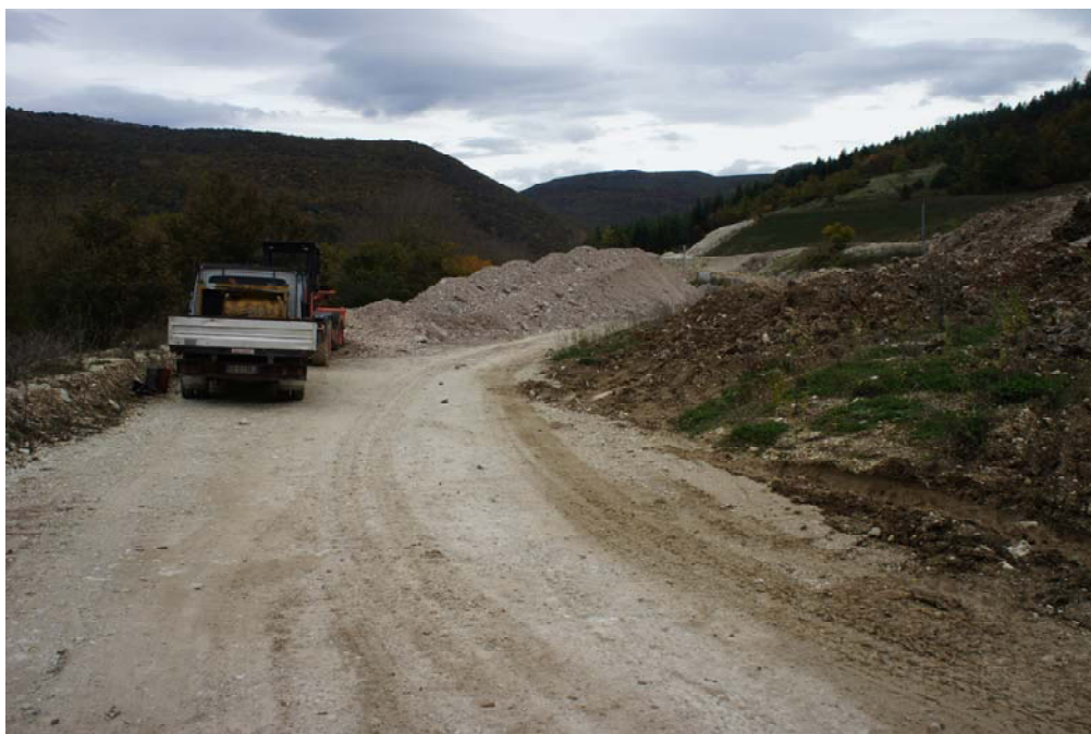
Figura 6.g - Immagine dell'area in fase di cantiere
