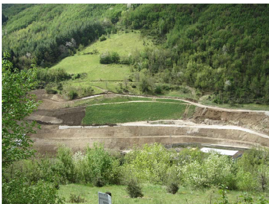
Figura 6.b - Immagine dell'area in fase di cantiere
