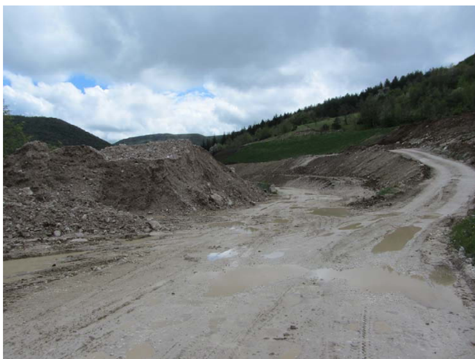
Figura 6.d - Immagine dell'area in fase di cantiere
