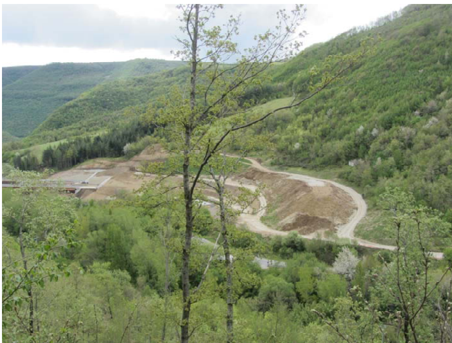
Figura 6.a - Immagine dell'area in fase di cantiere
