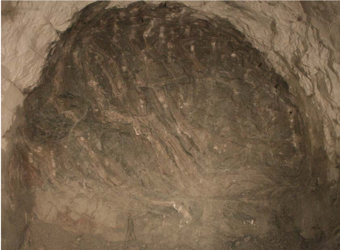
Abb. 6 Metamorphe Reichenhaller Schichten (707): metamorphe siliziklastische Sedimente (Quarzite, Phyllite) in Wechselfolge mit Anhydrit. (Erkundungsstollen Tm 12112)
