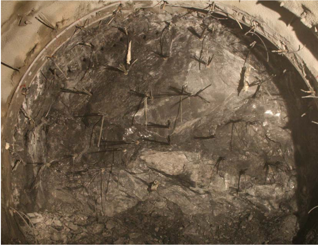
Abb. 3 graphitische Phyllonite und geschieferte Kataklastite mit Spiegelhamischen und plattig brechende Quarzite. (Erkundungstollen Tm 11879)
