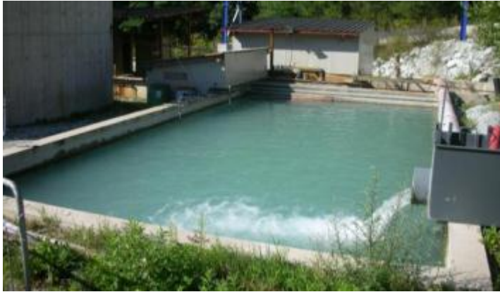
a) Vorsedimentation / Presedimentazione
