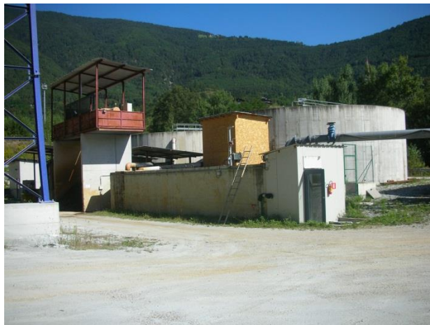
Unbefestigte Betriebsfläche der Behandlungsanlage Spazio di servizio non recintato dell'impianto di trattamento
