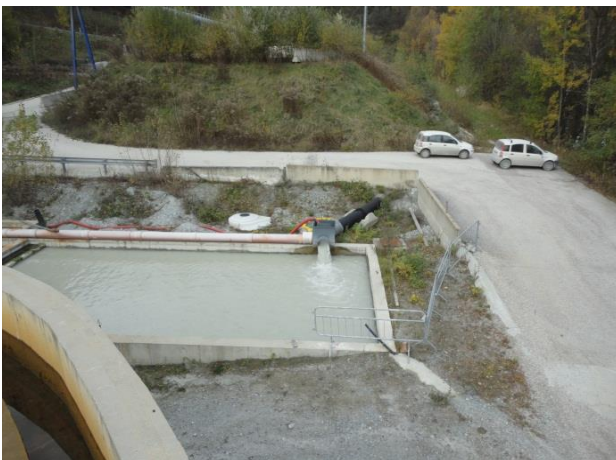
Zulauf in Vorsedimentationsbecken
