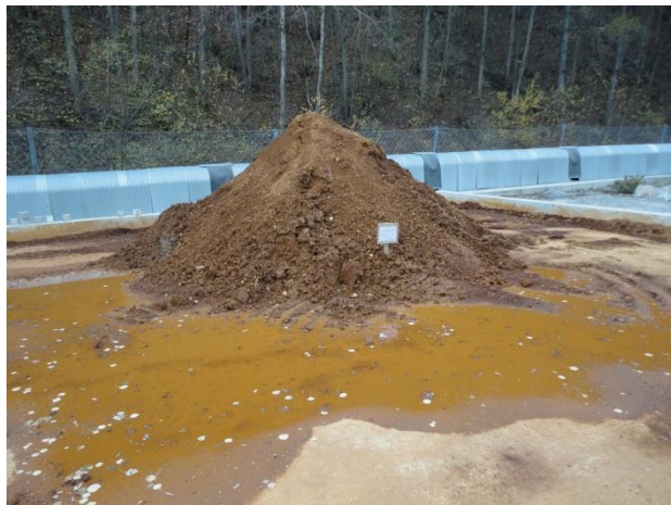
Schlammagerplatz mit Betonwanne Area di stoccaggio dei fanghi con vasca in cemento
