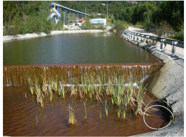
Überlauf Nachsedimentation mit H 2 O 2 -Dosierstelle Struttura di scarico con campionatore e dosaggio dell'H 2 O 2
