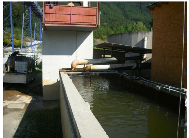
Zulauf zum Neutralisations- und Oxidationsbecken Afflusso nella vasca di neutralizzazione e ossidazione
