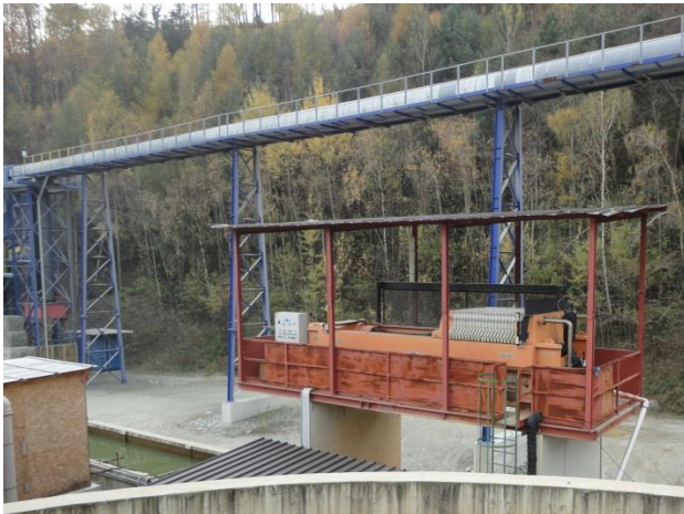
Schlammwässerung mit Kammerfilterpresse
