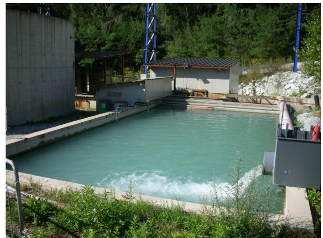
Vorsedimentation mit Zuleitung und Bypass zur Flockung / Koagulation
