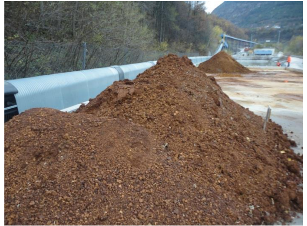
Befestigter, nicht überdachter Schlammagerplatz Area di stoccaggio dei fanghi recintata e scoperta
