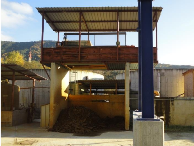
Schlammwässerung mit Abwurfbox Disidratazione dei fanghi con box di espulsione
