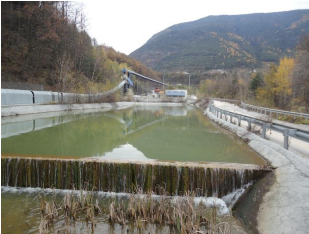
Nachsedimentation, Schönungsteich mit Ablauf Vasca di postsedimentazione, stagno con scarico
