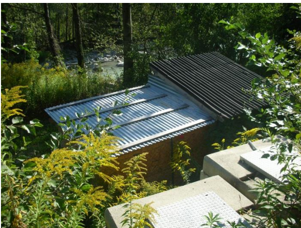
Ablaufgebäude mit Probenehmer und H 2 O 2 Dosierung Tracimazione vasca di postsedimentazione con punto di dosaggio dell'H 2 O 2
