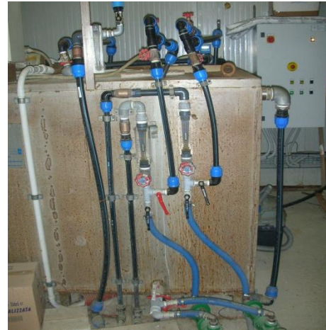
Flockmittelaufbereitungs- und Dosierstation Stazione di preparazione e dosaggio del flocculante
