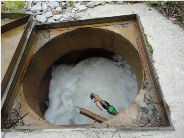
Ablaufschacht nach Neutralisations- und Oxidationsbecken Pozzo di scarico dopo la vasca di neutralizzazione e ossidazione
