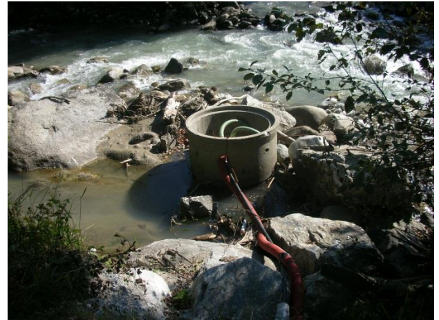
Messschacht im Eisack zur Kontrolle der Temperatur Pozzetto di misurazione nell'Isarco per il controllo della temperatura
