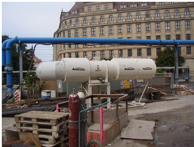
Abbildung 24: Entstaubungsventilator bei der Montage
