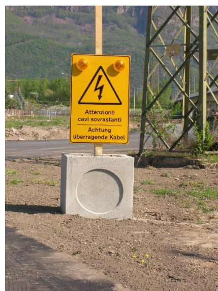
Figura 36: Cantiere di Genauen 2 – Segnaletica di pericolo delle linee elettriche aeree
