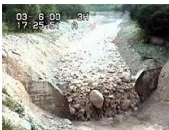
Abbildung 94: Murenabgang Während der Ausführung am Rückhaltebecken sind folgende Sicherheitsvorkehrungen vorgeschrieben:
