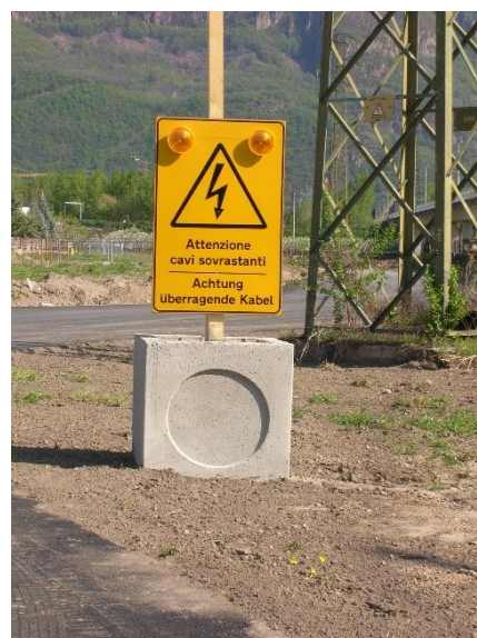
Figura 39: Cantiere di Sachsenklemme – Segnaletica di pericolo delle linee elettriche aeree
