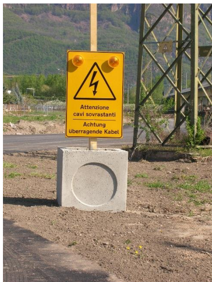
Abbildung 41: Baustelle Hinterrigger– Warnschilder (Freileitungen)
