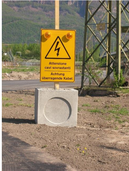
Abbildung 33: Baustelle Muls – Warnschilder (Freileitungen)
