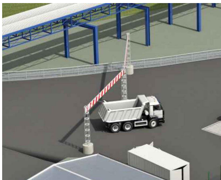
Abbildung 35: Baustelle Genauen 2 – Portal als Schutz vor Freileitungen
