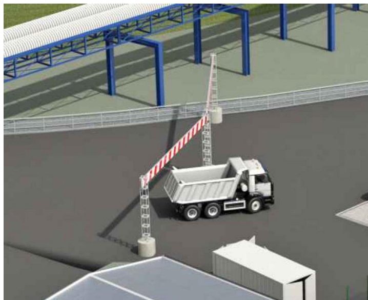
Abbildung 38: Cantiere di Sachsenklemme – Portale di protezione dalle linee elettriche aeree
