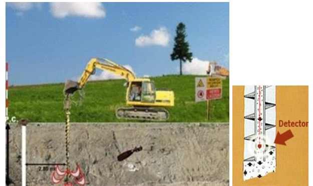
Figura 6: Bonifica profonda – Fase 1
