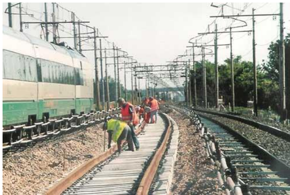
Abbildung 1: Sicherung von Baustellen an in Betrieb befindlichen Bahnstrecken
