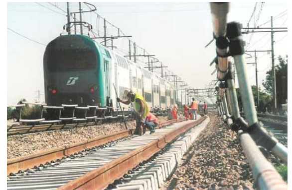
Figura 1: Protezione dei cantieri su linee ferroviarie in esercizio
