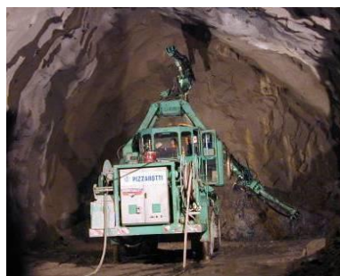
Figura 2: Perforazione fori di volata
