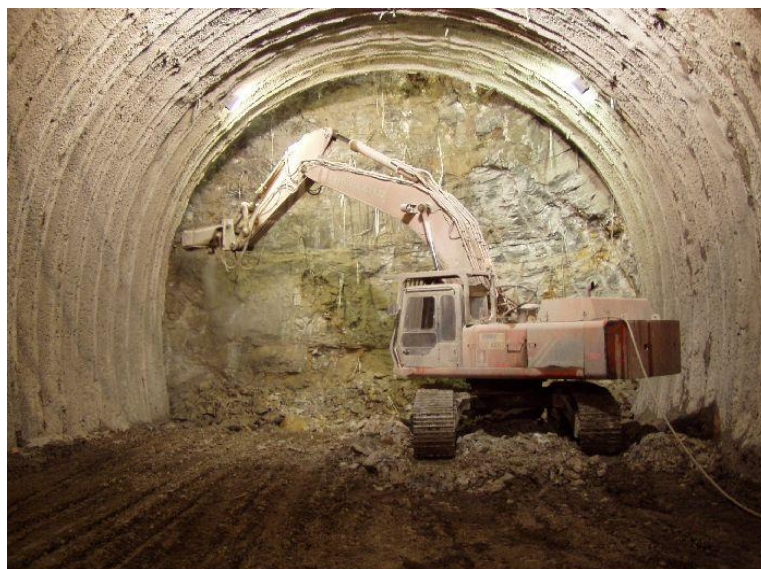
Abbildung 1: Vortrieb mit Abbruchhammer
