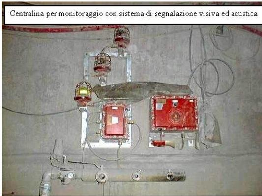
Abbildung 5: Automatischen Überwachungsanlage
