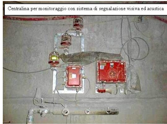
Figura 5: Centralina di monitoraggio automatico
