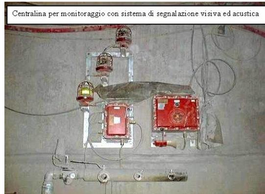
Figura 3: Centralina di monitoraggio automatico
