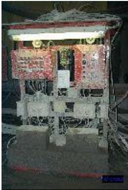
Jede Baustelle muss mit einem Messgerät ausgestattet sein, welches die Gaskonzentration in der Atmosphäre bestimmen kann, da beim Ausbruch der auszuführenden Tunnels das Vorhandensein von explosivem Gasgemisch nicht ausgeschlossen werden kann. In besonderer Weise muss die Präsenz von Methan, Kohlendioxyd, Kohlenoxyd, salpetriger Gase und Schwefelwasserstoff bestimmt werden können und müssen deren Werte in einem eigenen Register vermerkt werden.
