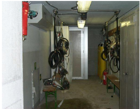
Figura 8: Dotazioni del Container
