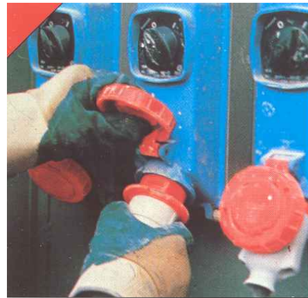
MODO CORRETTO DI STACCARE UNA SPINA MOBILE DA UNA PRESA FISSA. BEWEGLICHE STECKER AUS EINER FESTEN STECKDOSE RICHTIG HERAUSZIEHEN.
