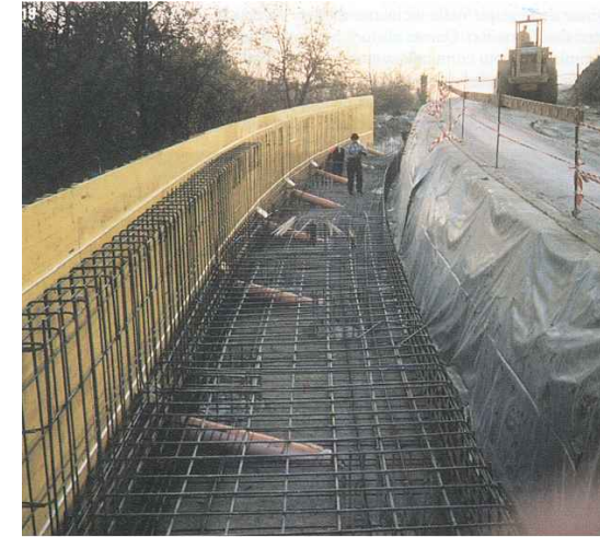
LO SCAVO DEVE ESSERE PROTETTO DALLA PIOGGIA CON UN TELO IMPERMEABILE PER GARANTIRE LA STABILITÀ IN QUALSIASI CONDIZIONE. DIE GRUBE MUSS MIT EINER UN DURCHLÄSSIGEN PLANE VOR REGEN GESCHÜTZT WERDEN, UM DEREN STABILITÄT BEI ALLEN WITTERUNGSBEDINGUNGEN ZU GEWÄHRLEISTEN.
