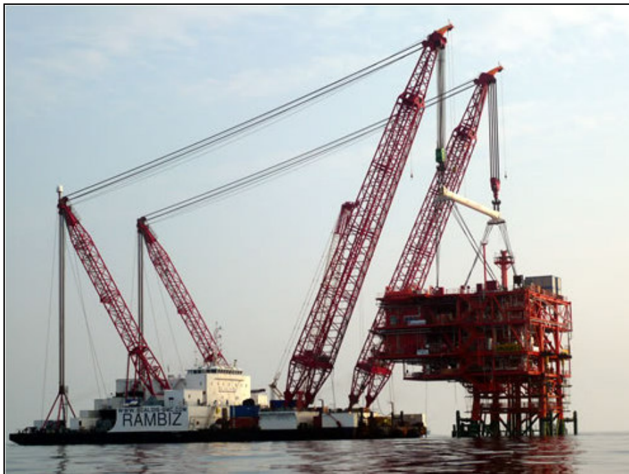
Figura 2.18: Installazione del Deck
