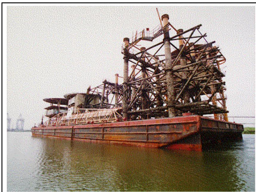
Figura 2.27: Trasporto delle Strutture Rimosse
