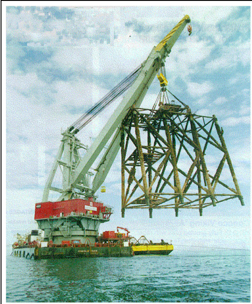
Figura 2.24: Sollevamento Completo di un Jacket
