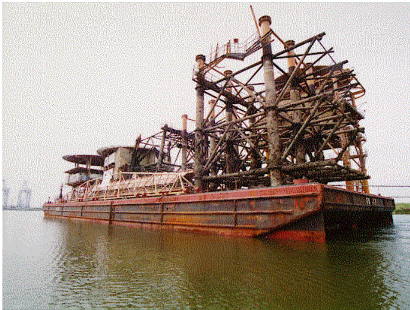
Figura7. 6 - Trasporto delle Strutture Rimosse
