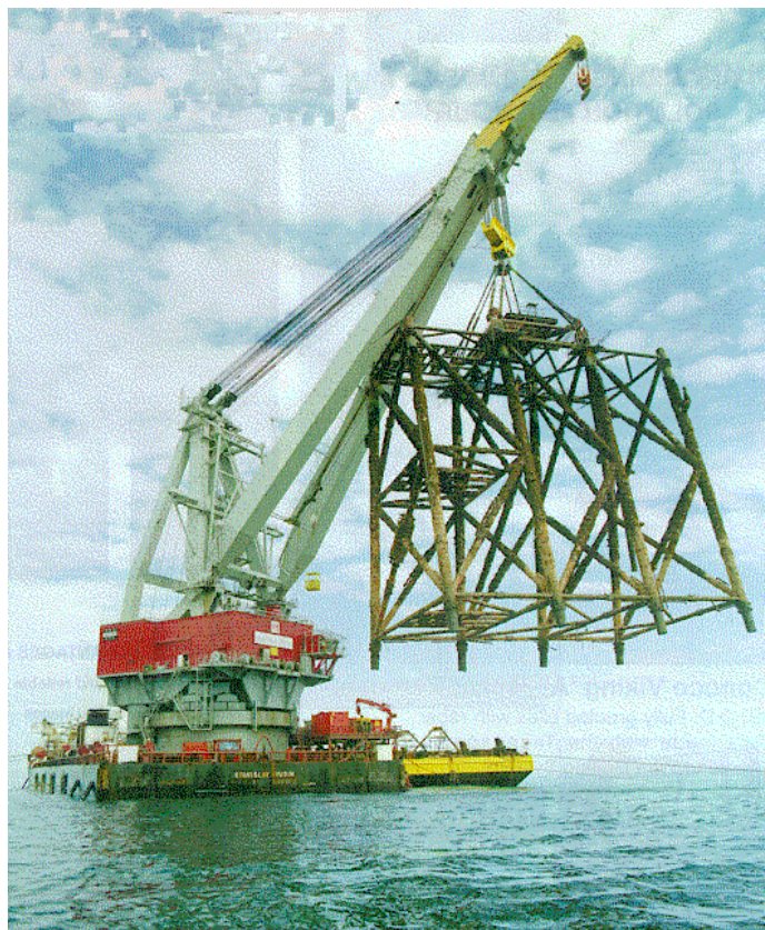
Figura 7.3- Sollevamento completo di un Jacket
