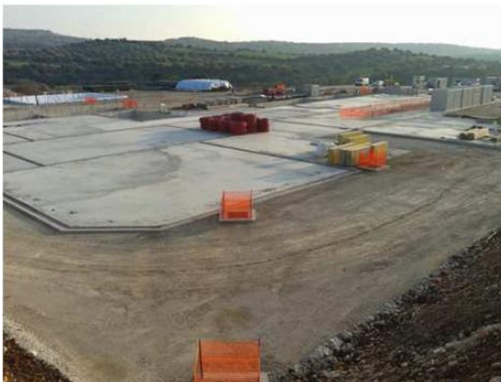
Figura n. 1: approntamento piazzale di perforazione autorizzato dal D.D.G. n. 672
