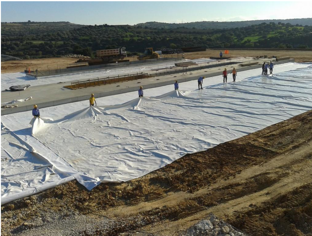
Figura n. 83: fase di impermeabilizzazione del piazzale
