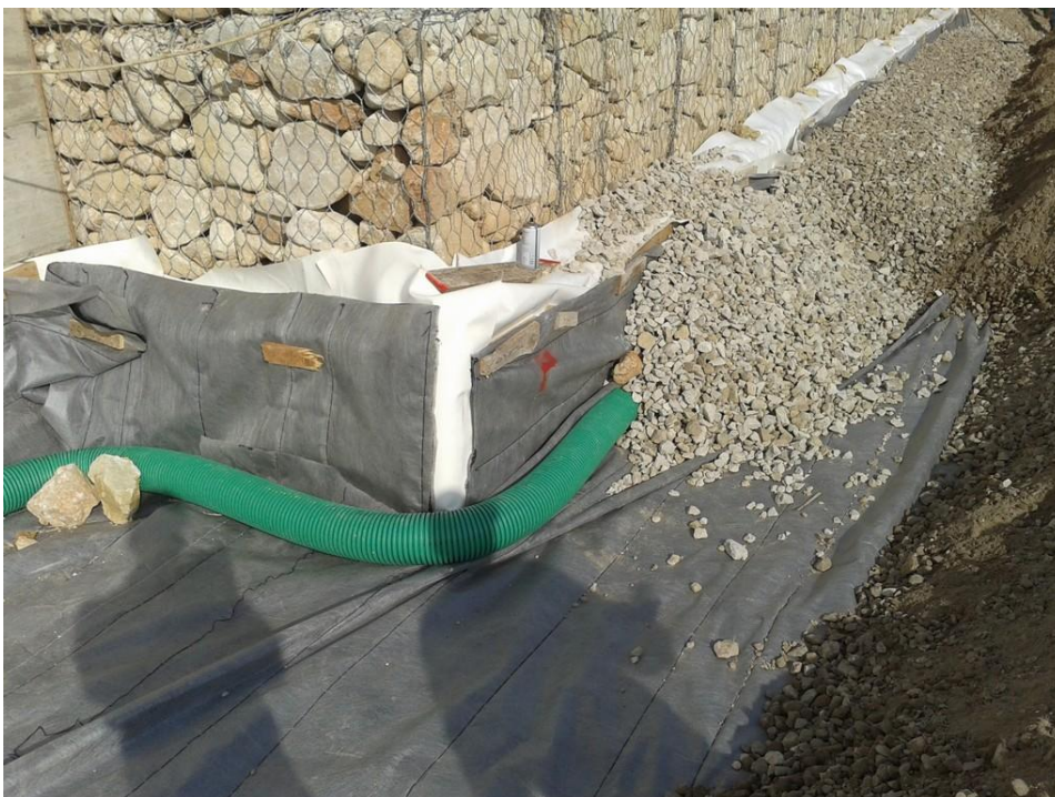
Figura n. 84: particolare della fase di impermeabilizzazione del piazzale
