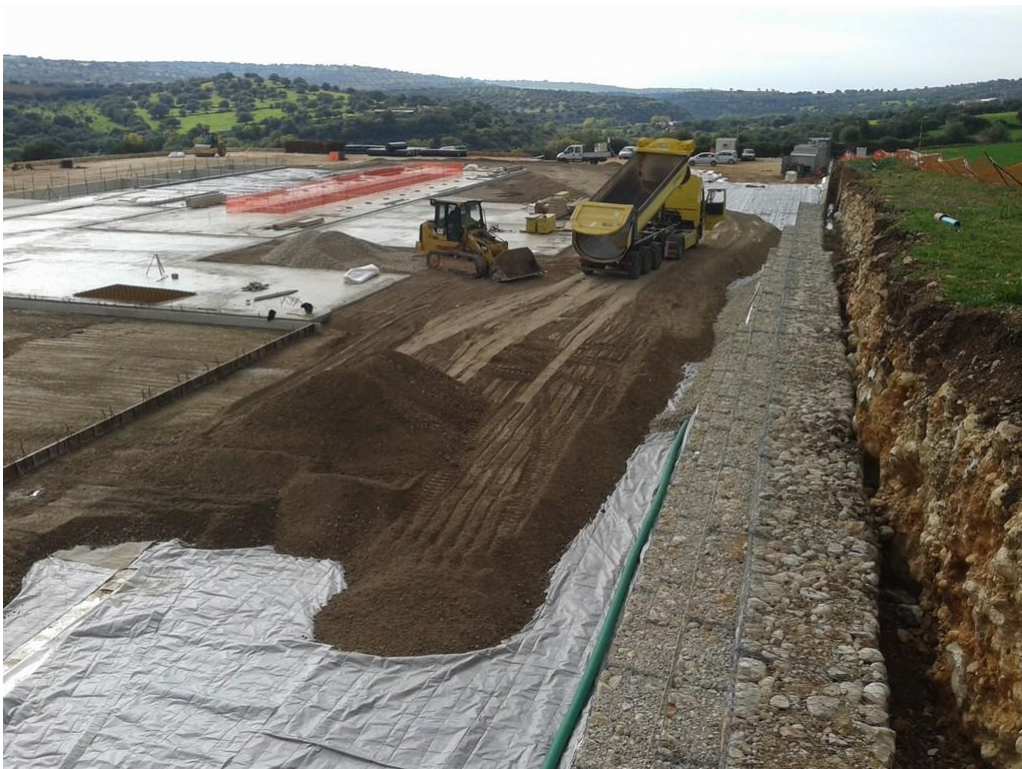
Figura n. 82: fase di impermeabilizzazione del piazzale
