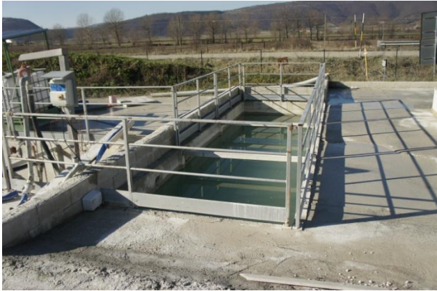
Figura 7 – Vasche per l'accumulo ed il trattamento dei reflui
