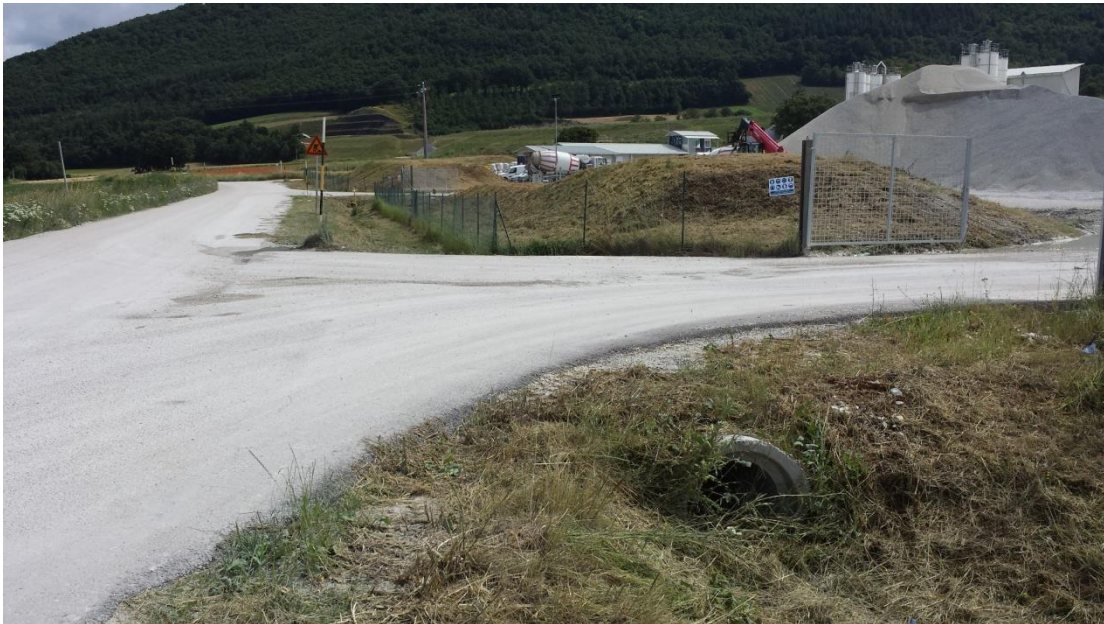
Figura 8–Attraversamento provvisorio in corrispondenza di uno degli accessi al cantiere
