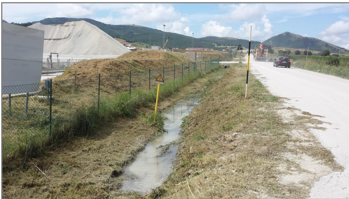
Figura 5 – Sedime predisposto per la sistemazione degli impianti
