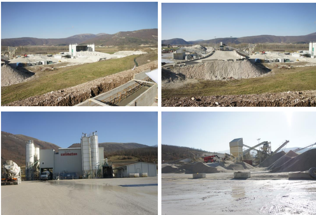
Figure 6 - Immagini dell'impianto in fase di produzione
