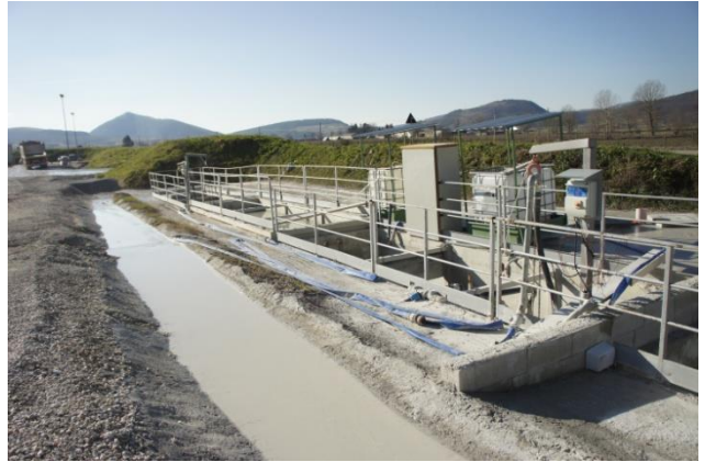
Figura 7 – Vasche per l'accumulo ed il trattamento dei reflui
