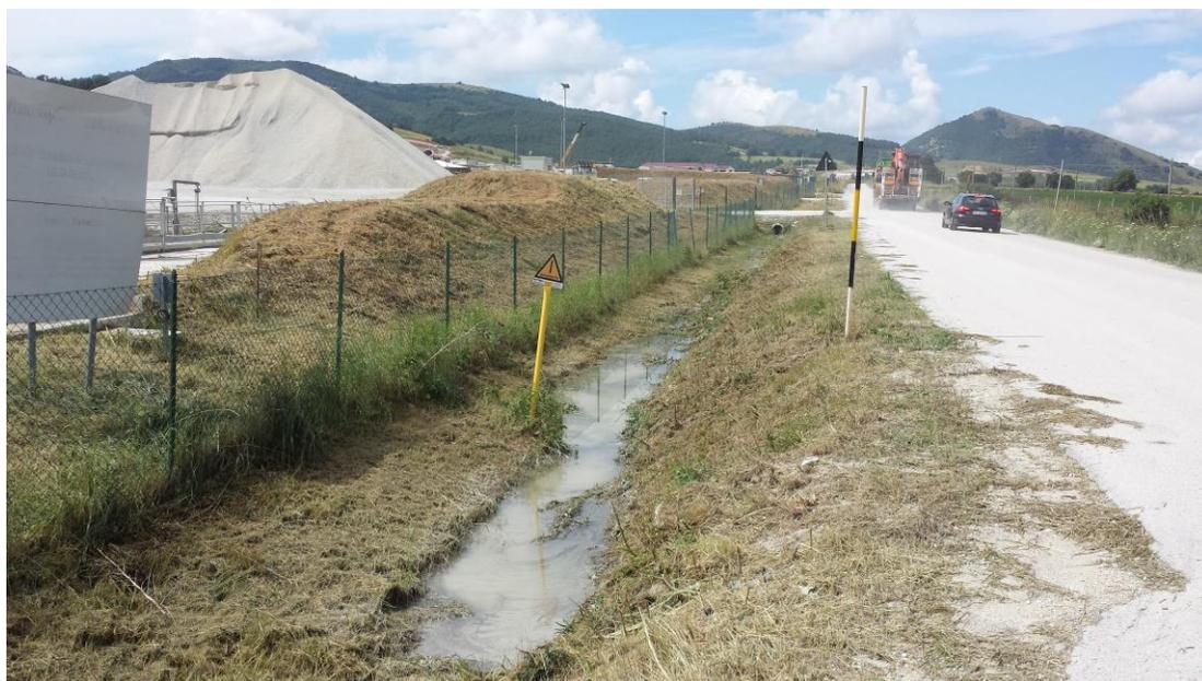
**Foto 3–Fosso di guardia lungo la S.P. 50 “Fonte delle Mattinate” che costeggia la FBeton 6**
