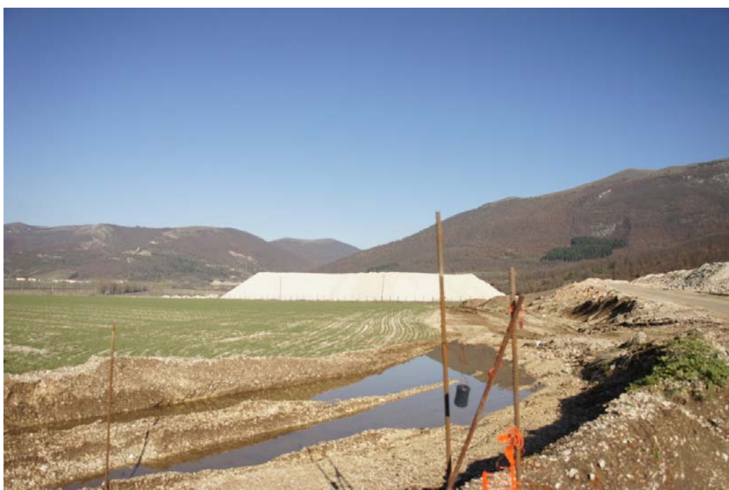
Figura 6 – Immagine dell'area di cantiere Ante Operam .
