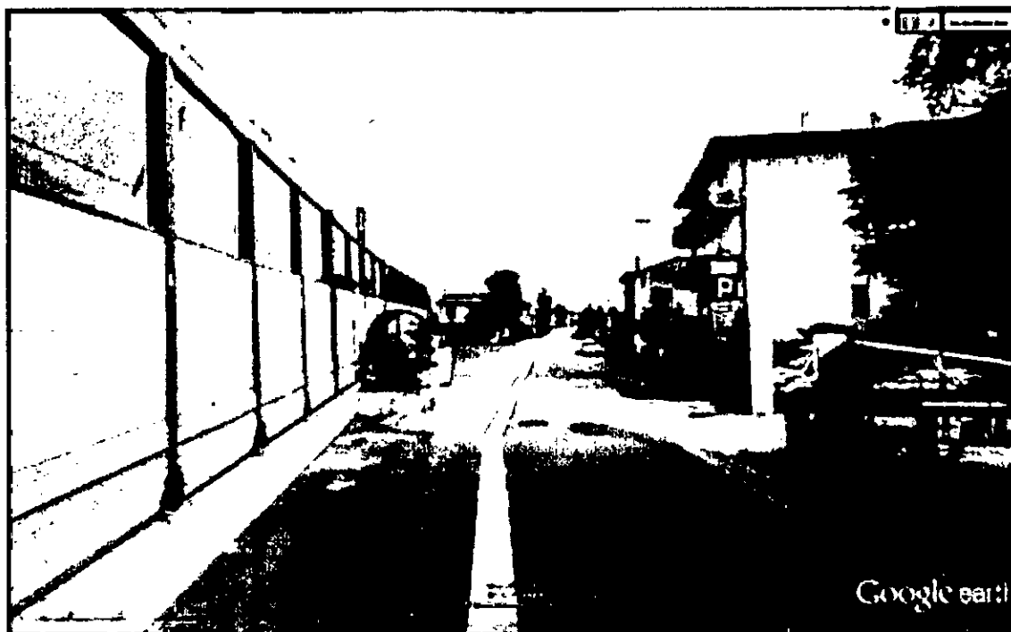
Barriere antirumore lungo una strada in prossimità di edifici esistenti
