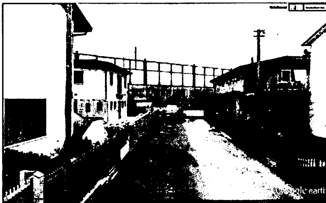
Barriere antirumore in vicinanza a edifici esistenti
