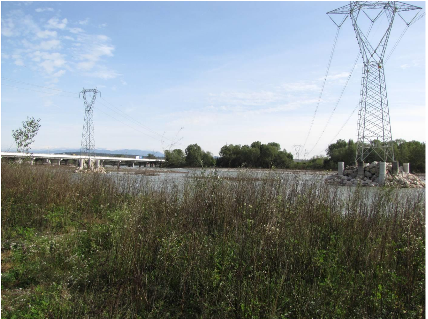
Fig. 6: Immagine scattata il 30/10/2013 dalla riva destra del Fiume Isonzo in prossimità del ponte autostradale, presso Villesse
