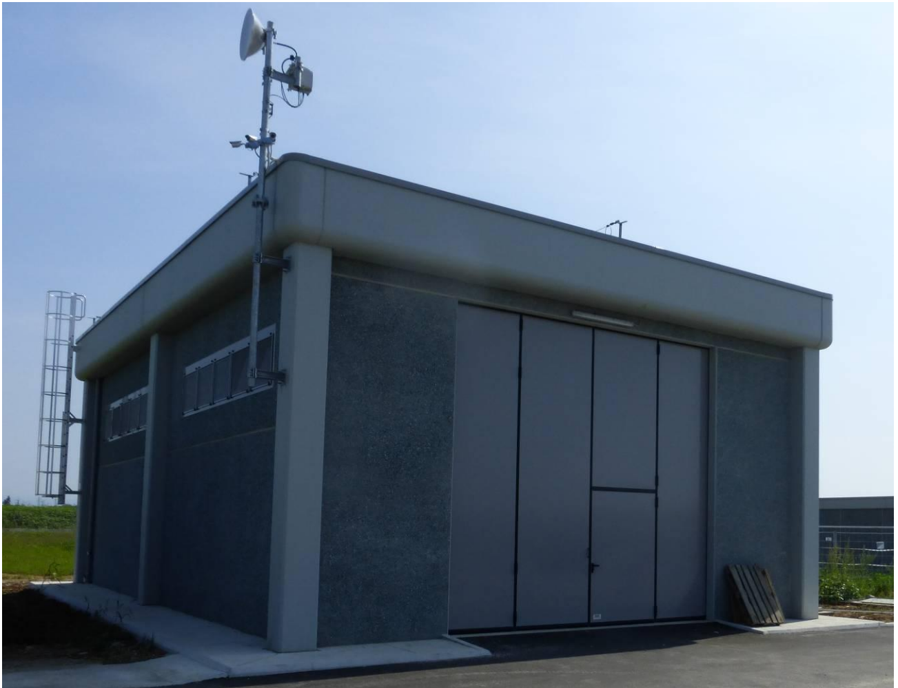
Foto 3 – Vista dal lato ingresso del fabbricato magazzino
