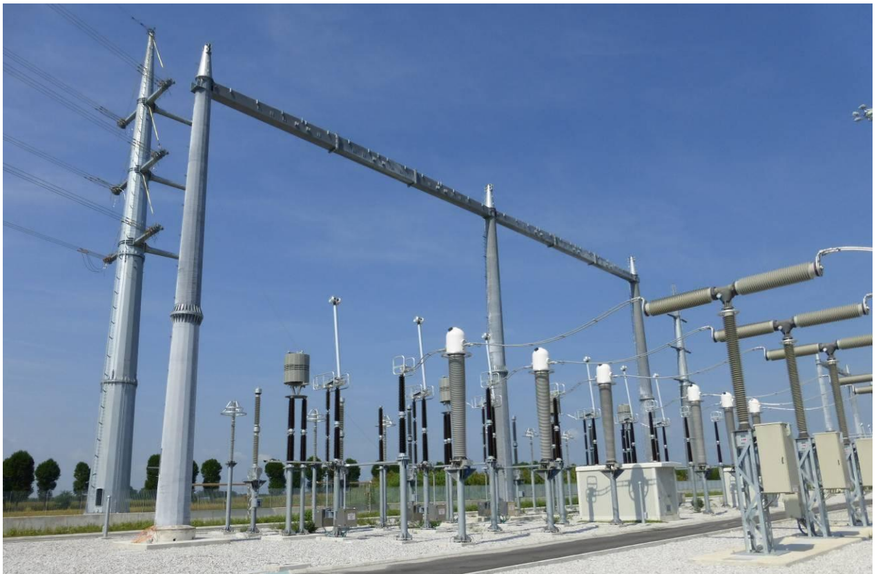
Foto 8 – Ingresso linea d.t. 380 kV "S.E. Redipuglia - S.E. Udine Sud"
