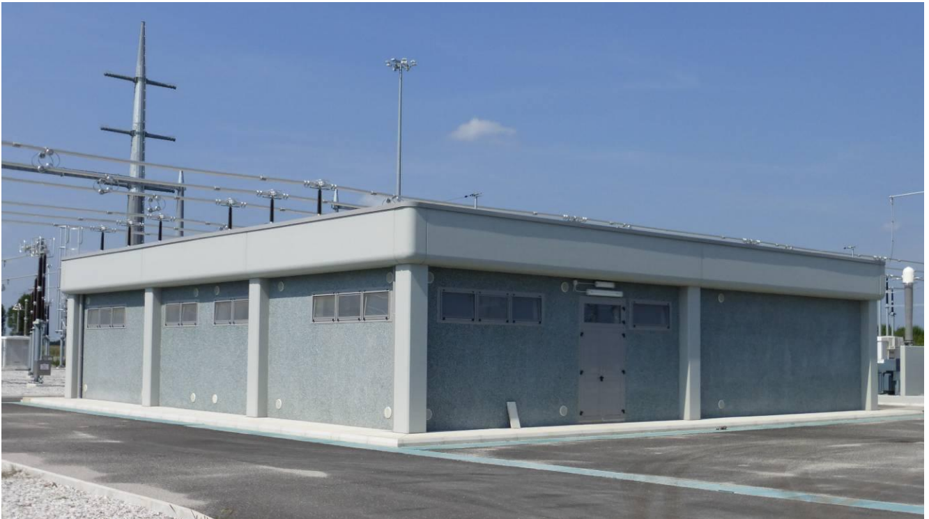
Foto 5 – Vista dal lato ingresso del fabbricato Servizi Ausiliari
