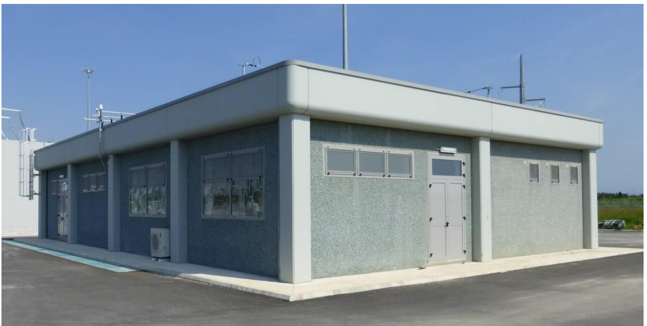
Foto 4 – Vista dal lato ingresso del fabbricato comandi
