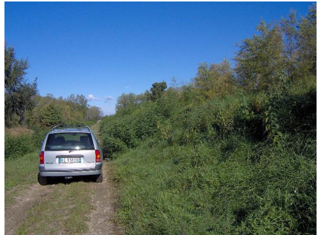
Figura 20 – l'argine in destra orografica del Torrente Torre in località Tapogliano
