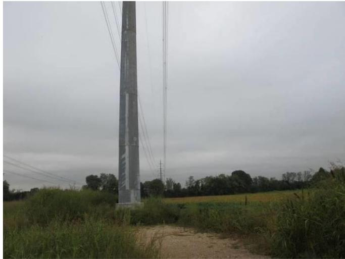
**Figura 37 - Nella foto è inquadrato il sostegno n 6 dell'elettrodotto 380 kV in d.t. "Udine Ovest-Redipuglia". È evidente come il consumo di suolo determinato dalla base del sostegno sia alquanto esiguo se paragonato a quanto accade coi tralicci tradizionali.**
