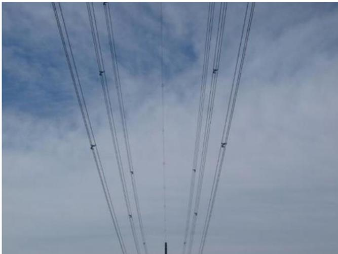
**Figura 35 - Recenti installazioni di spirali di segnalazione per avifauna (linea Trino – Lacchiarella loc. Bereguardo) - Vista d'insieme**
