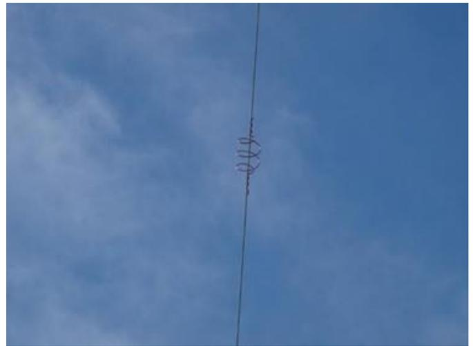
**Figura 36 - Recenti installazioni di spirali di segnalazione per avifauna (linea Trino – Lacchiarella loc. Bereguardo) - Particolare**
