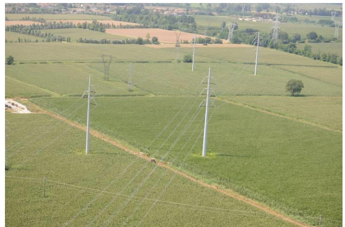
Figura 14. Schema di confronto traliccio/sostegno tubolare per linee elettriche 380 kV.
