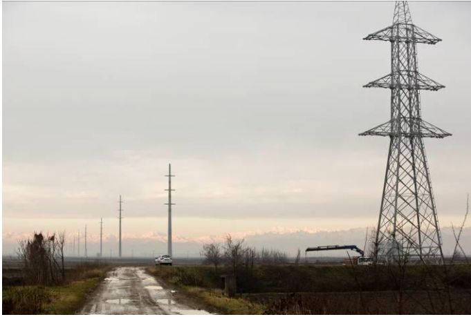
Figura 15. Riprese fotografiche di alcuni elettrodotti realizzati/in corso di realizzazione con sostegni tubolari e tralicci tradizionali.
