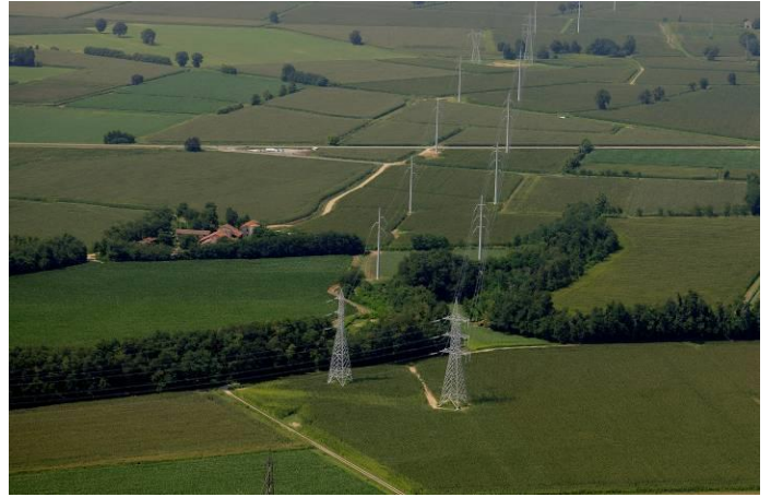
Figura 15. Riprese fotografiche di alcuni elettrodotti realizzati/in corso di realizzazione con sostegni tubolari e tralicci tradizionali.
