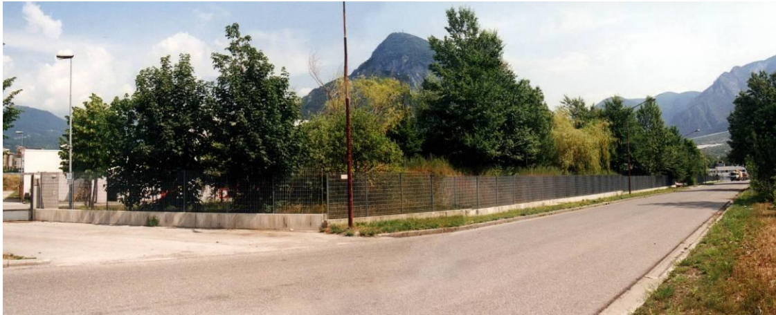
Figura 17: Fascia boscata tampone, depuratore consortile – Tolmezzo (UD), Foto G. Sauli
