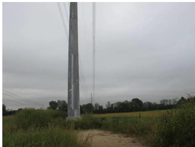
Figura 13. Nella foto è inquadrato il sostegno n 6 dell'elettrodotto 380 kV in d.t. "Udine Ovest-Redipuglia". È evidente come il consumo di suolo determinato dalla base del sostegno sia alquanto esiguo se paragonato a quanto accade coi tralicci tradizionali.
