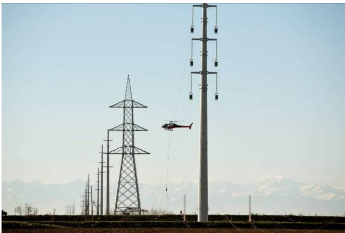
Figura 14. Schema di confronto traliccio/sostegno tubolare per linee elettriche 380 kV.
