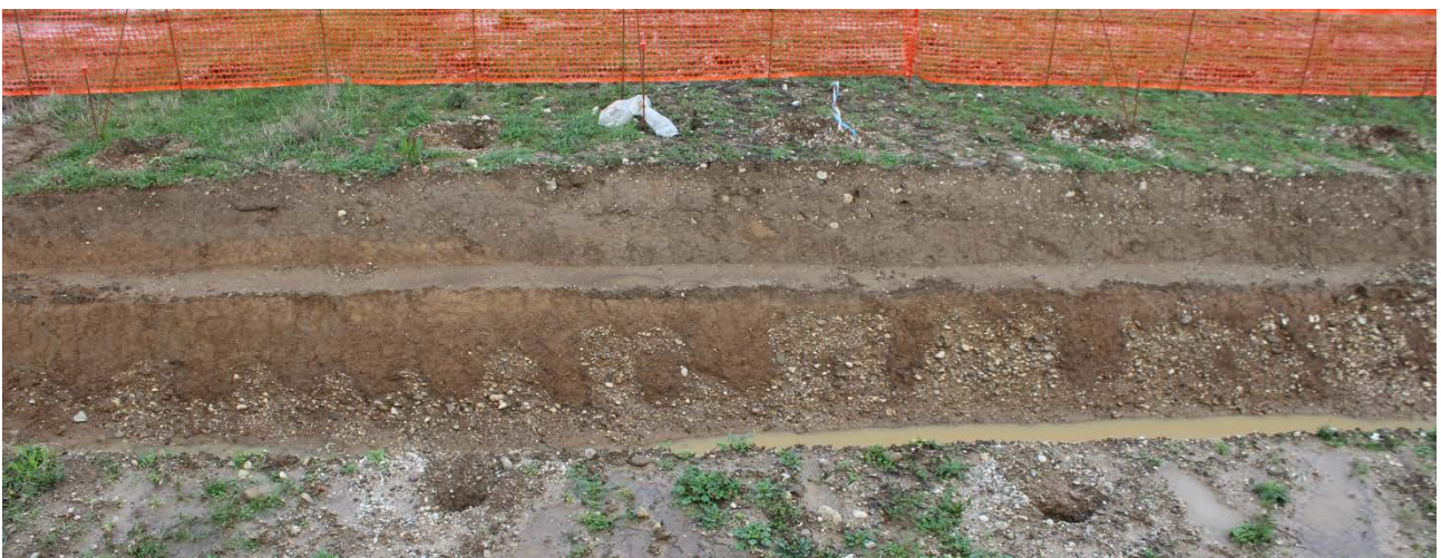
Fig. 12: panoramica della canaletta di scolo a Nord – sezione Nord
