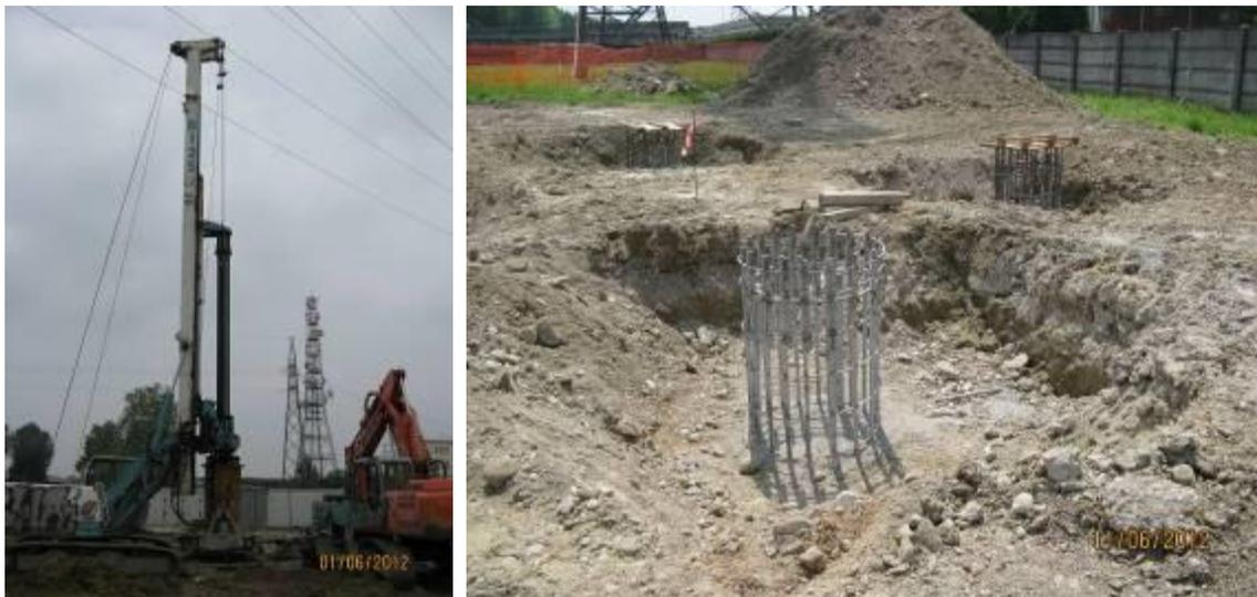
Figura 66 - Esempio di realizzazione di una fondazione su pali trivellati.
