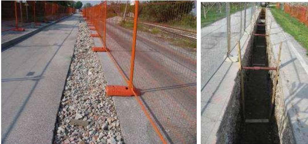
**Figura 73 - Taglio dell'asfaltatura e scavo aperto**
