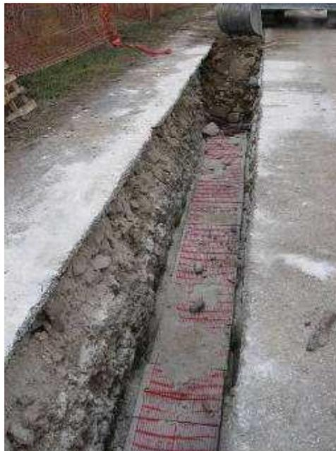
**Figura 75 - Rinterro con posa delle piastre di protezione e rete in PVC**
