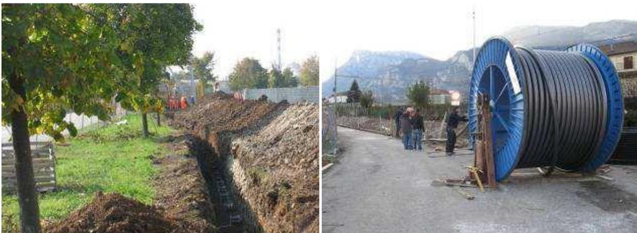
**Figura 74 - posa rulli lungo lo scavo e stendimento del cavo**
