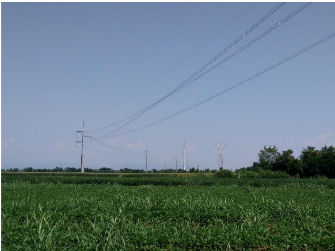
**Figura 77 - Variante della linea 380kV Planais-Udine Ovest entrata in esercizio a maggio 2015 (tratta 1 del progetto; a destra sono visibili i nuovi sostegni della linea 380kV in d.t. già realizzati e quelli s.t.)**
