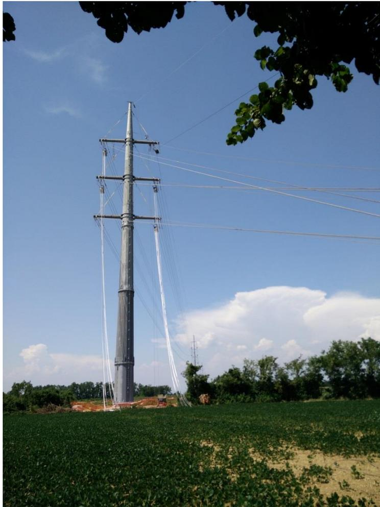
**Figura 79 - Sostegno di amarro in fase di tesatura conduttori (tratta 2 del progetto)**
