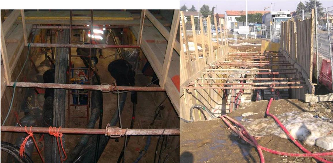
Figura 51 - Vista interna ed esterna di buca giunti in fase di realizzazione
