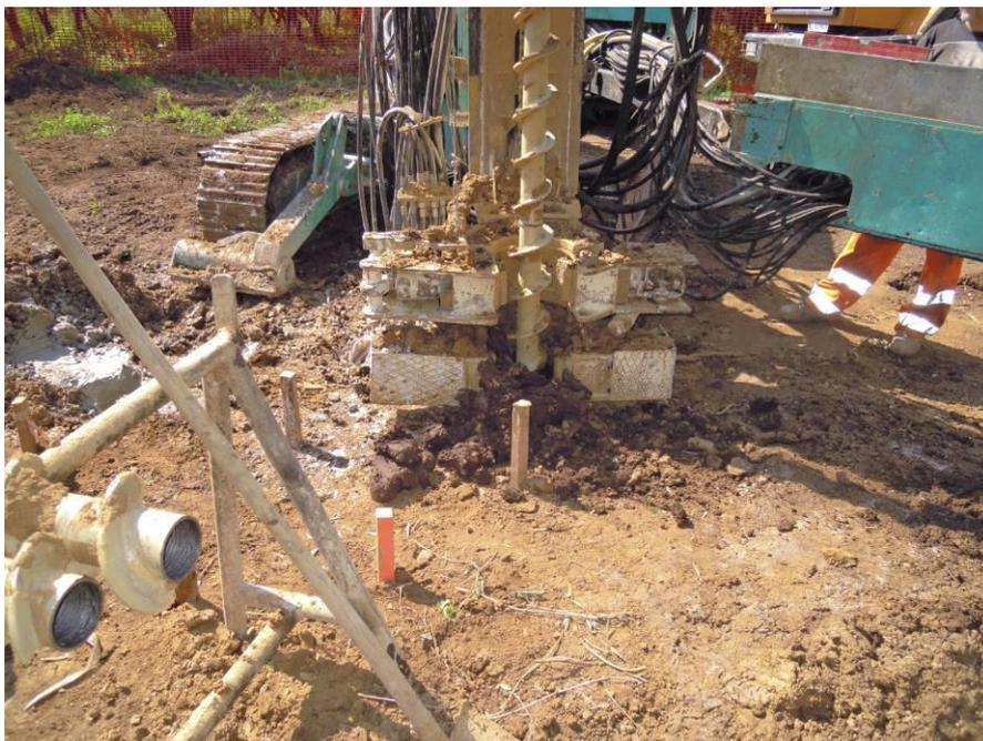
**Figura 70 - Macchina operatrice per la realizzazione di micropali tubfix; sistema di scavo mediante trivella elicoidale**
