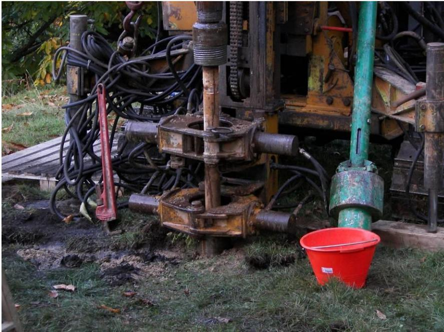
**Figura 69 - Macchina operatrice per la realizzazione di micropali tubfix; sistema di scavo a rotopercuSSIONE**
