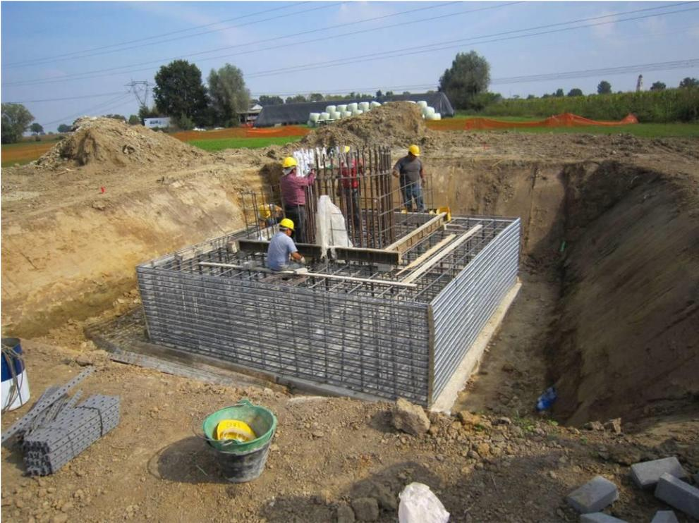
**Figura 64 - Realizzazione di fondazione superficiale tipo plinto a monoblocco per un sostegno monostelo. Nell'immagine si può osservare la fase di cassetteratura**
