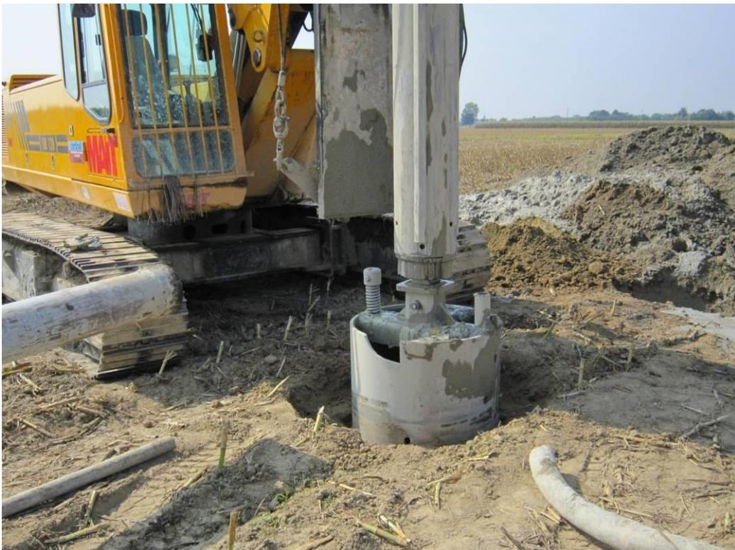
**Figura 68 - Macchina operatrice per la realizzazione di pali trivellati. Particolare del "carotiere"**
