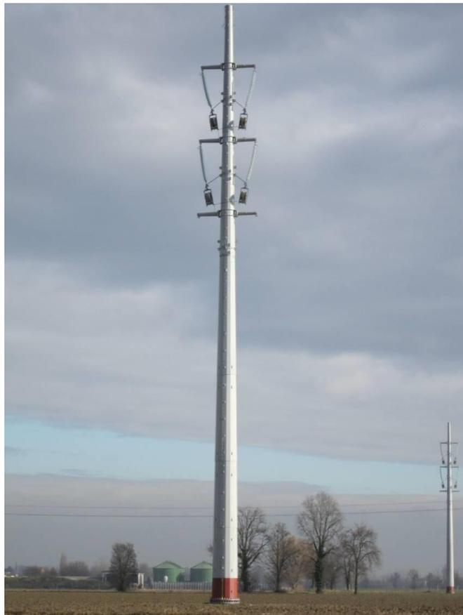
**Figura 62 - Sostegno monostelo montato. Si notino le carrucole collegate alle catene degli isolatori, fase che precede la "tesatura" dei conduttori**
