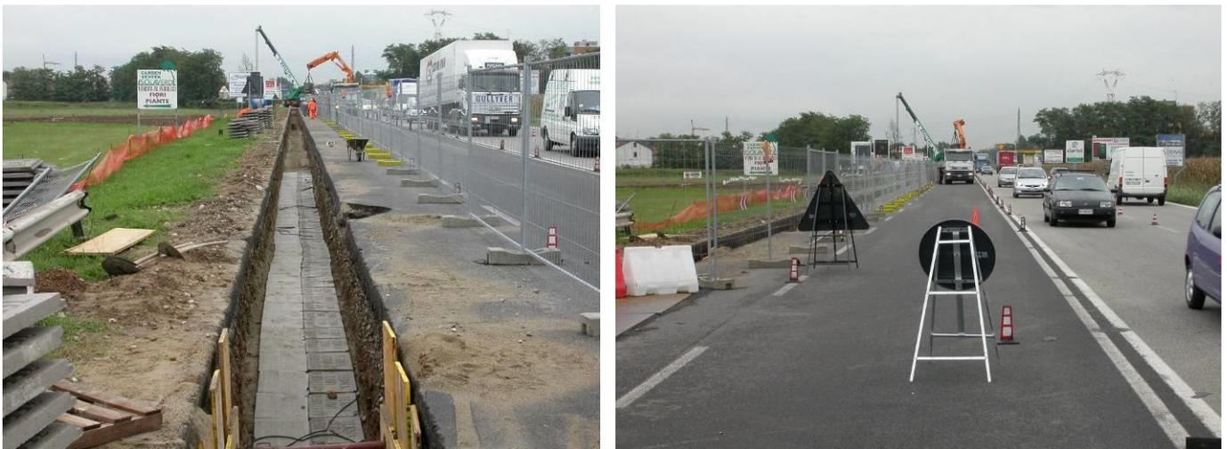
**Figura 54 - Esempio di posa di una terna di cavi su strada statale per linea 380 kV.**
