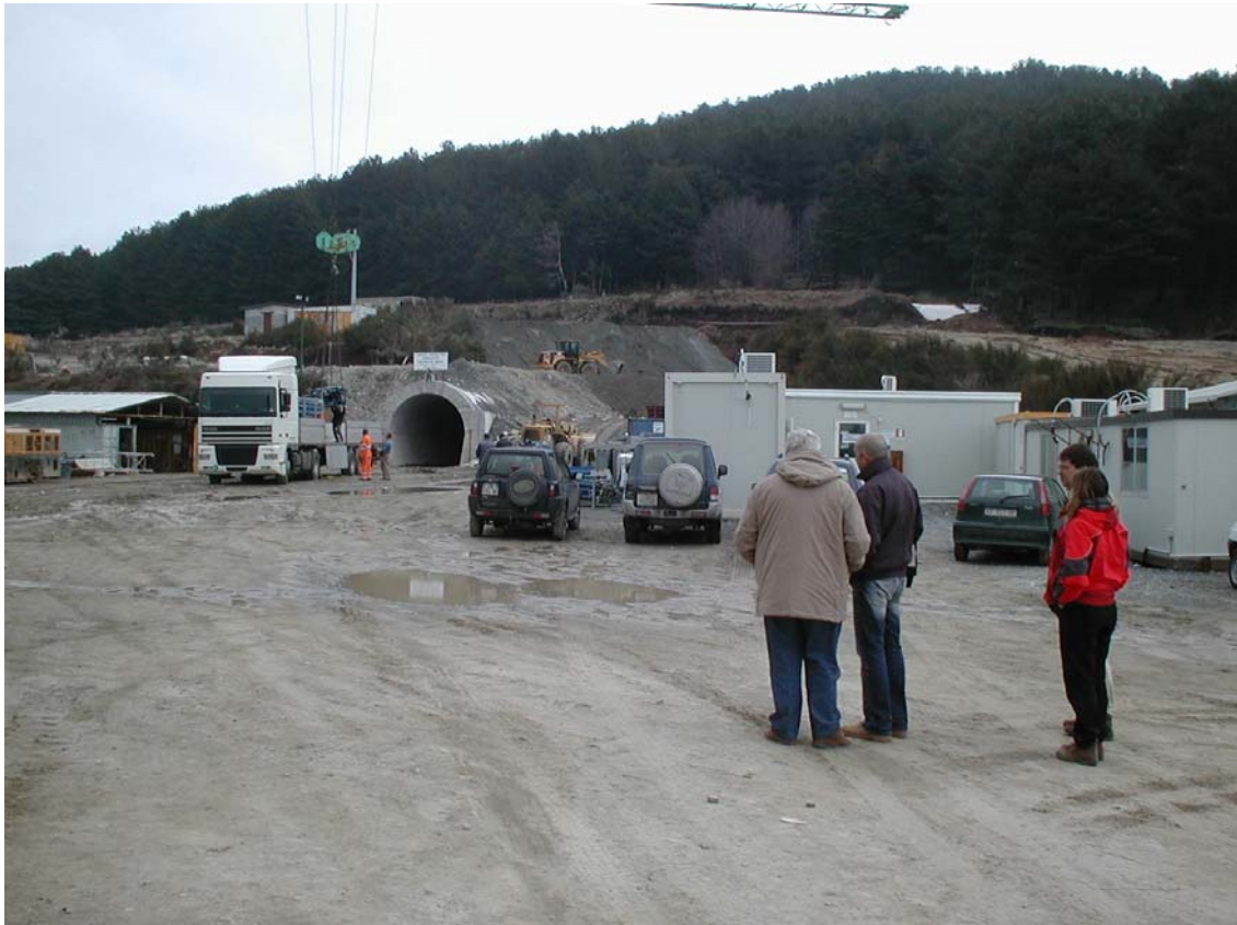
Fig. 1: Sbocco della Galleria di derivazione, presso Monte Cendri
