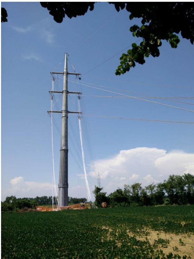
**Figura 13 - Sostegno di amarro in fase di tesatura conduttori (tratta 2 del progetto)**
