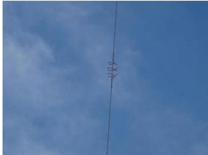
**Figura 37 - Recenti installazioni di spirali di segnalazione per avifauna (linea Trino – Lacchiarella loc. Bereguardo) - Particolare**
