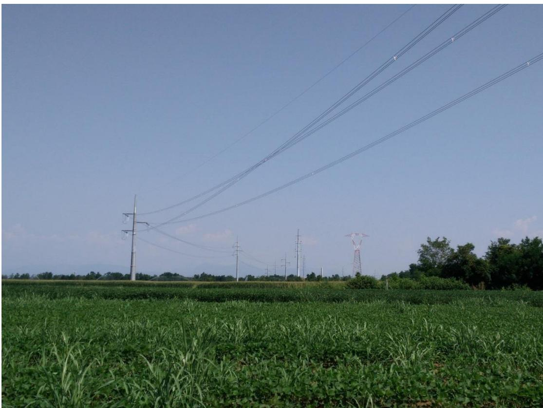
**Figura 11 - Variante della linea 380kV Planais-Udine Ovest entrata in esercizio a maggio 2015 (tratta 1 del progetto; a destra sono visibili i nuovi sostegni della linea 380kV in d.t. già realizzati e quelli s.t.)**
