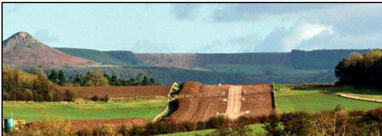
Figura 1h Posa di cavi interrati in campagna
