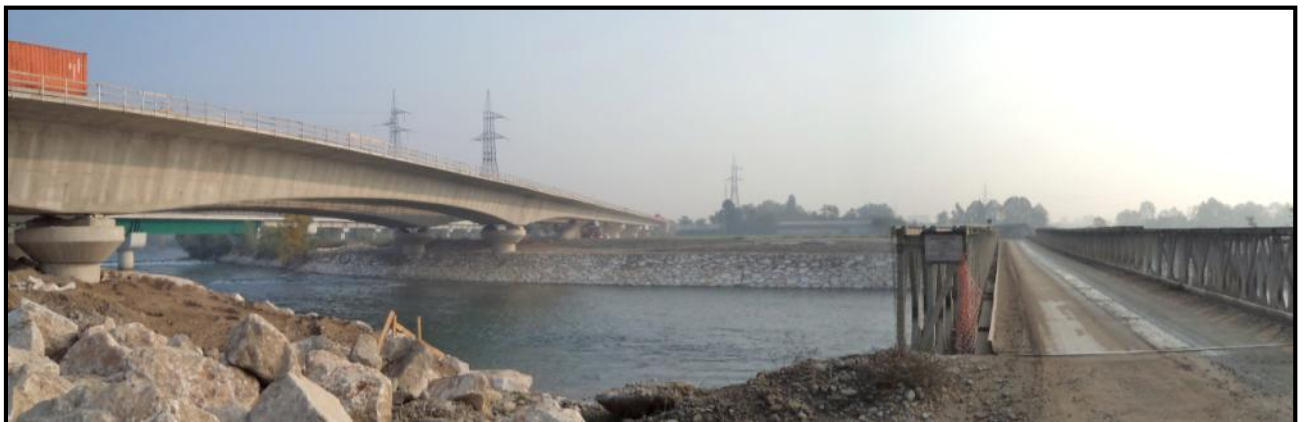
Figura 2.3b L’attraversamento del Fiume Adda del Cantiere delle Infrastrutture
