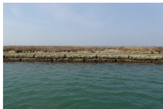
Fig. 26 Protezione di barene con burghe
