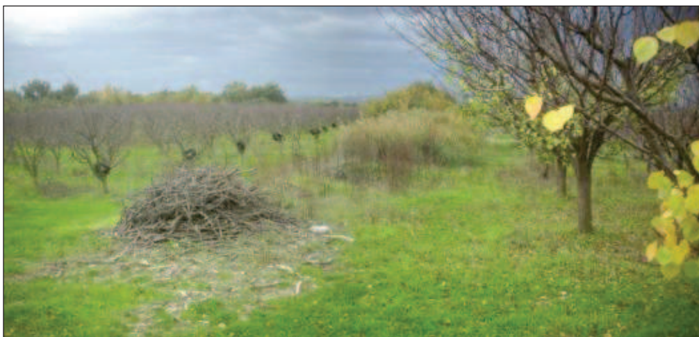
Figura 5.14: Foto con il particolare dell'Argine fluviale della Conca interrotto.
