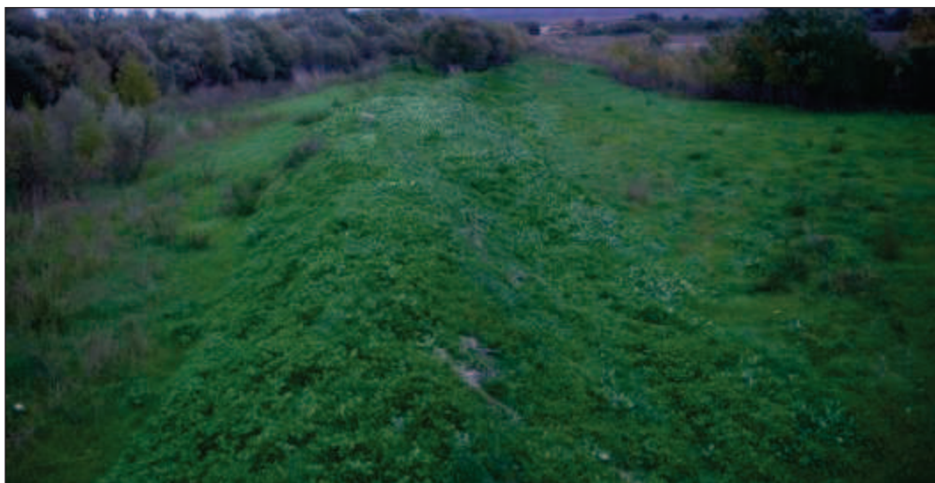
Figura 5.39: Foto rappresentativa dell'Arginatura nella piana alluvionale del Fiume Fortore appena a valle del Ponte sulla S.P. 46.
