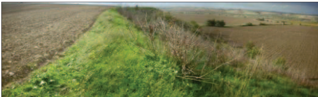
Figura 5.42: Foto rappresentativa del ciglio del terrazzo fluviale del Torrente Taina dove è ubicato il sostegno 317.
