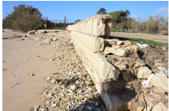
Figura 5 Muro di contenimento in pietra (nodo A)
