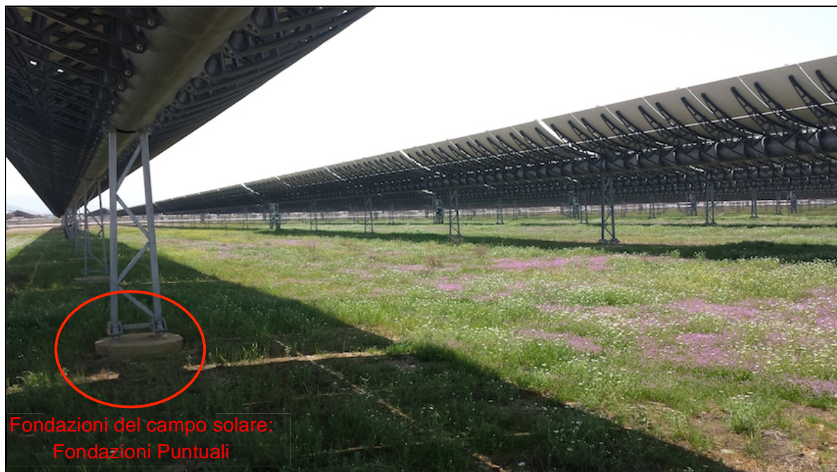
Figura 8: Fondazioni del campo solare
