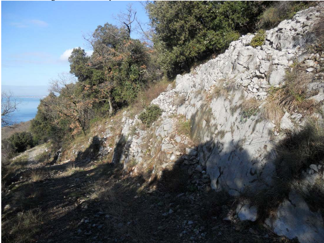
SG6 Affioramento roccioso oggetto del rilievo geomeccanico. Si notano i gradoni suborizzontali e gli strati verticalizzati.
