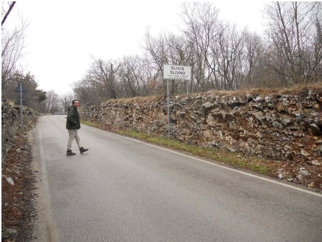
SG4 Pareti N dell'affioramento sulla strada per Slivia.
