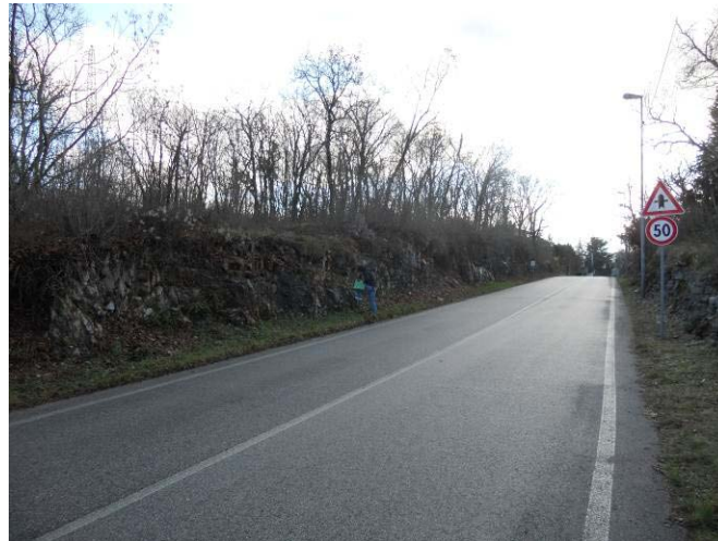
SG5 Strada provinciale e pareti rocciose su cui è stato eseguito il rilievo geomeccanico.
