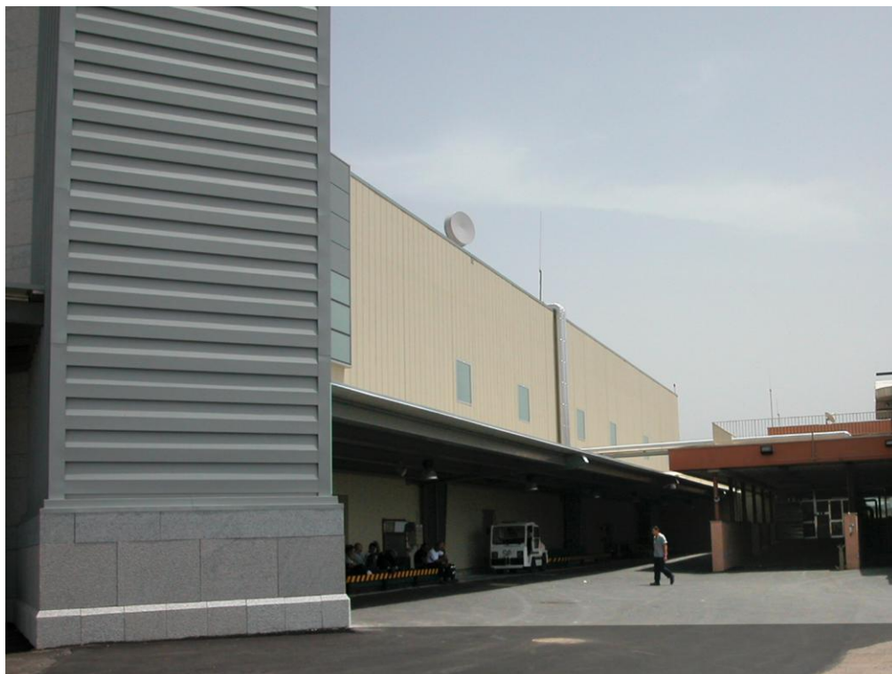
FOTO 2 – VISTA ZONA DI INTERVENTO (lato pista)
